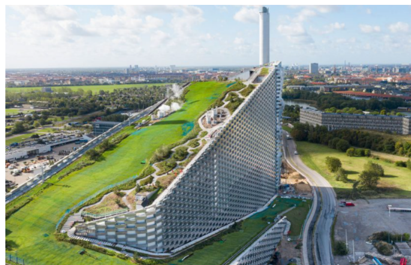
廃棄物発電所で遊びながら学ぶ機会をつくるコペンヒルの様に
